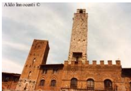
La torre Rognosa e il Palazzo del Podestà
